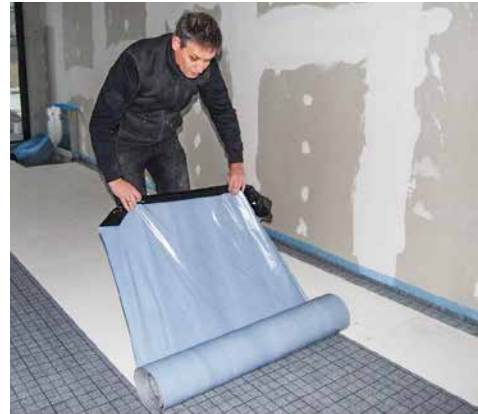
Eine Person reicht für die Verlegung, polyKLETT FLAT für die Verlegung von Standardestrichen
